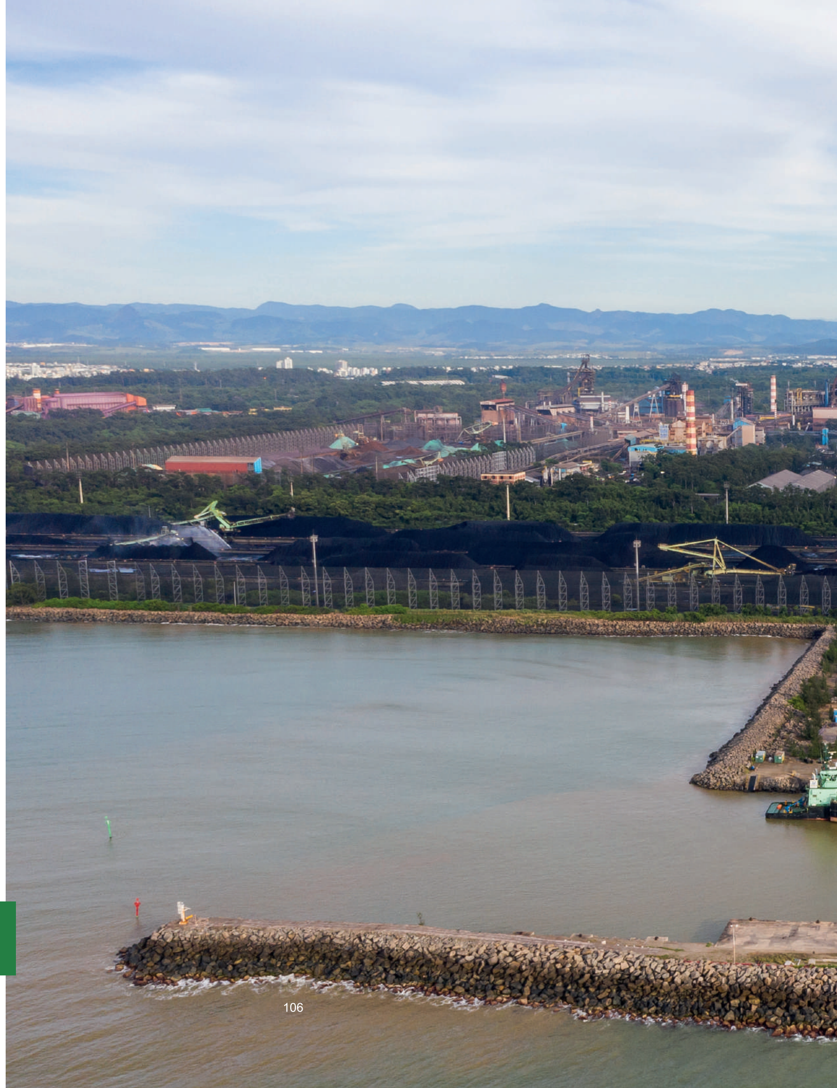
Vista geral da Usina de Tubarão (CST) da ArcelorMittal/Divulgação: ArcelorMittal
