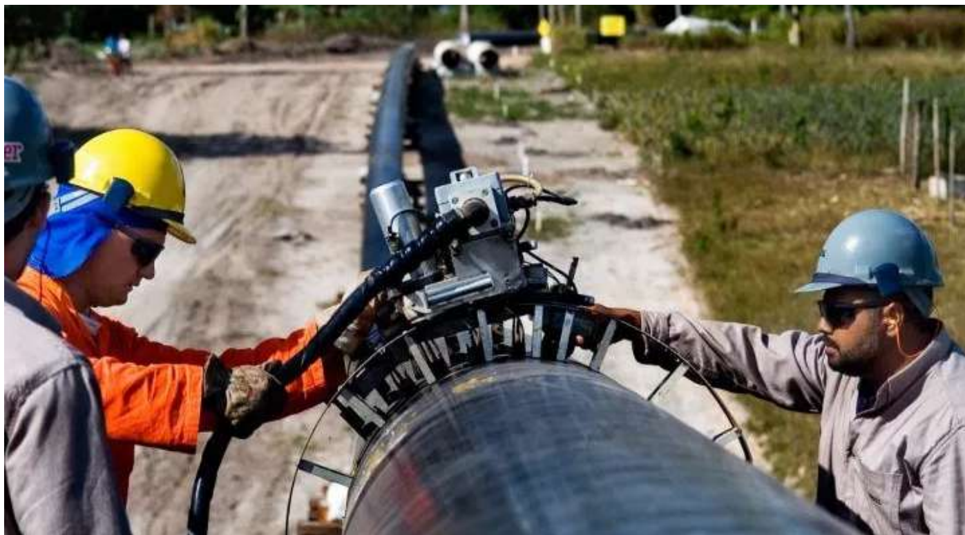
Gasoduto Catu-Pilar, Projeto Malha do Nordeste Fase I – Queiroz Galvão
